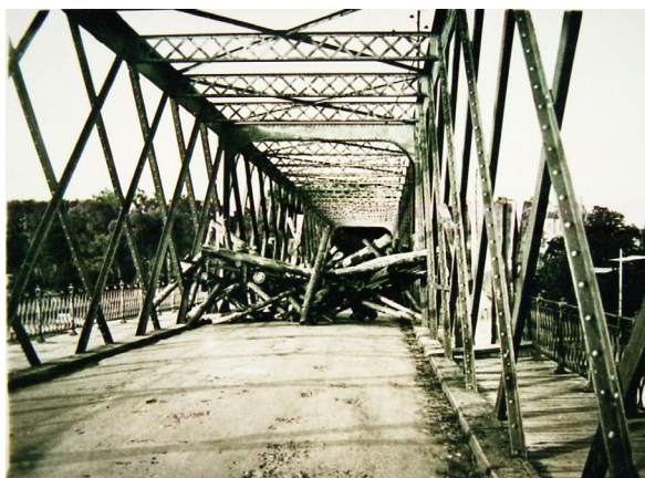
Barrage sur le pont de la Garonne
